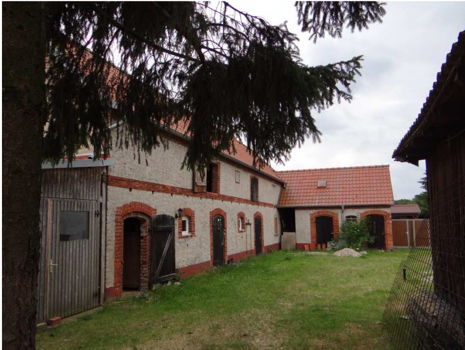
Nebengebäude des Grundstückes straßenseitig in gutem Zustand
