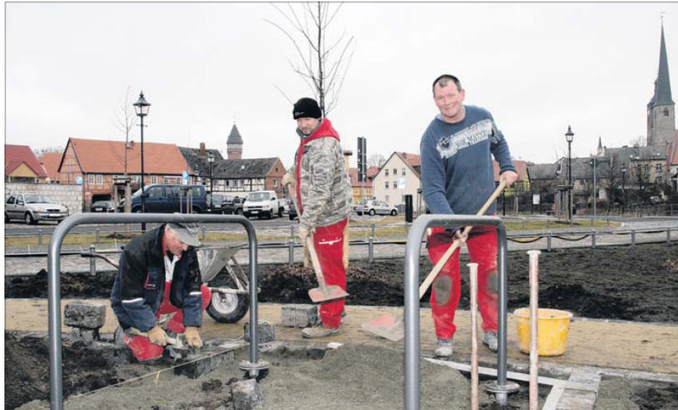
Auch der Mehrgenerationenspielplatz an der Ecke Deichstraße/Schulstraße in Burg ist Teil der Laga-Achse zwischen dem Goethepark und Flickschupark. Gestern legten Dieter Alsleben, Karsten Giesecke und Toni Wendorff (v.l.) von einer Magdeburger Baufirma bei den Fahrradständern Hand an. Der Spielplatz ist jeden Tag gut besucht. Foto: Mario Kraus
