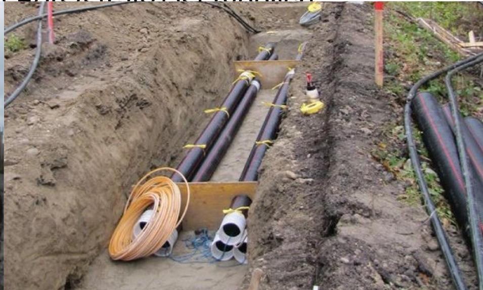
Bild 2 Verlegung von 2x 110 kV Kabel (Leerrohre)
