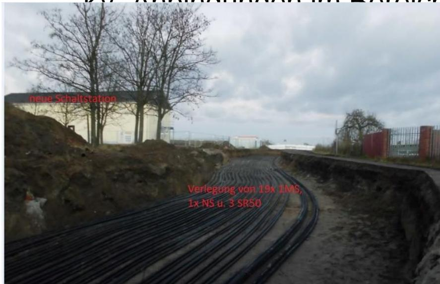
Bild 1: Verlegung von 15x MS-Kabel der SWBEN
